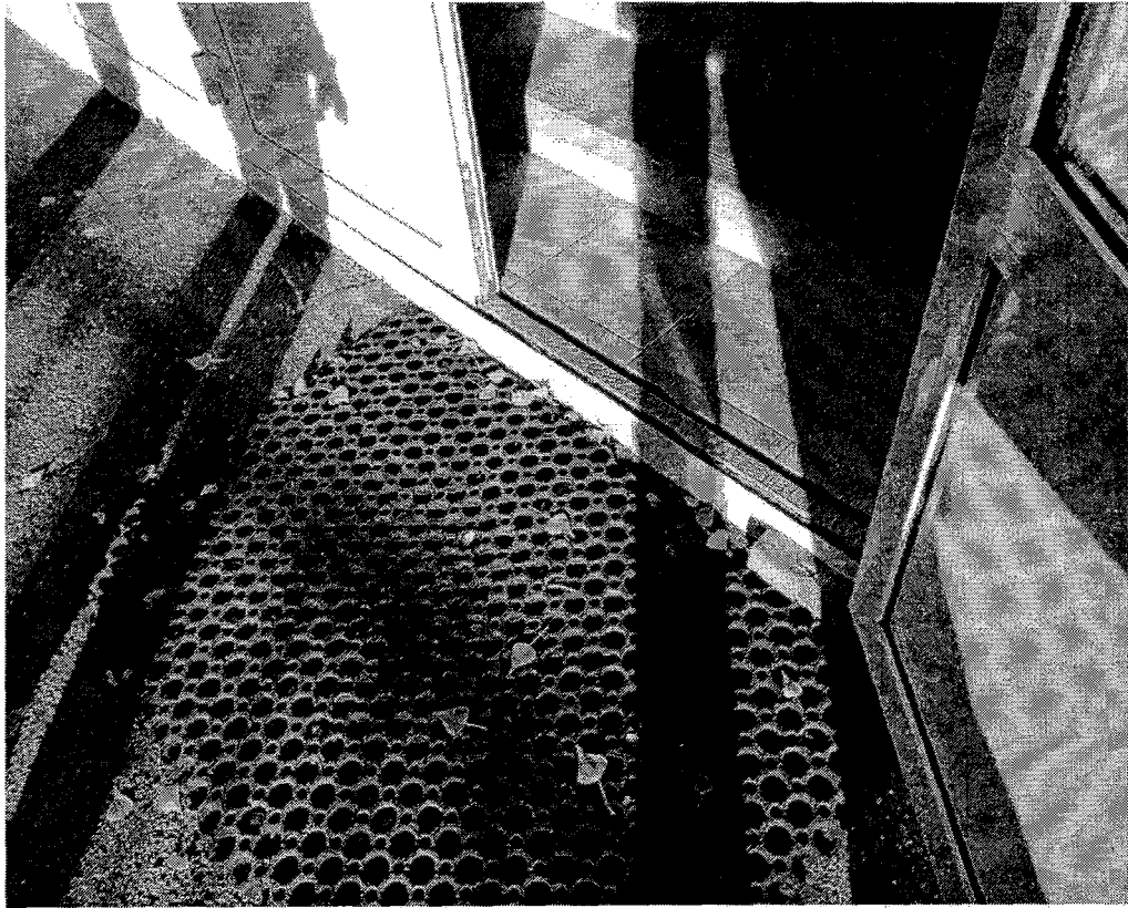
Дверь (входная, главный вход) – Фото №11
