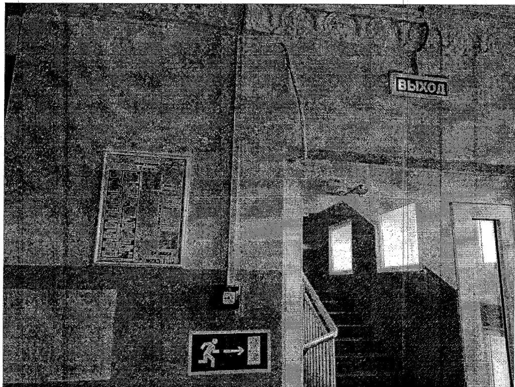
Пути эвакуации – Фото №50
