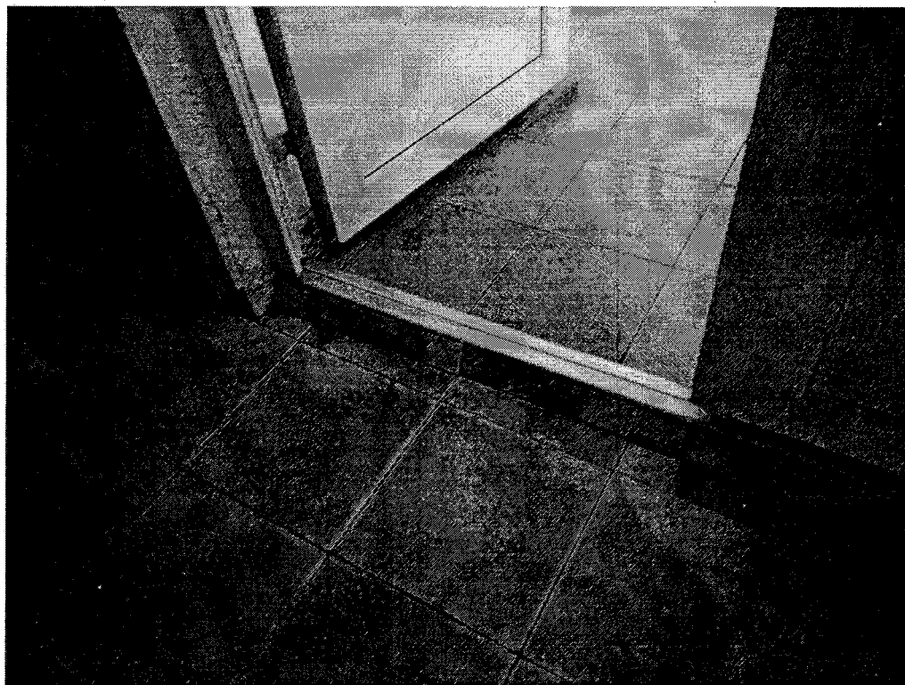
Дверь (из тамбура №2 в вестибюль) – Фото №32
