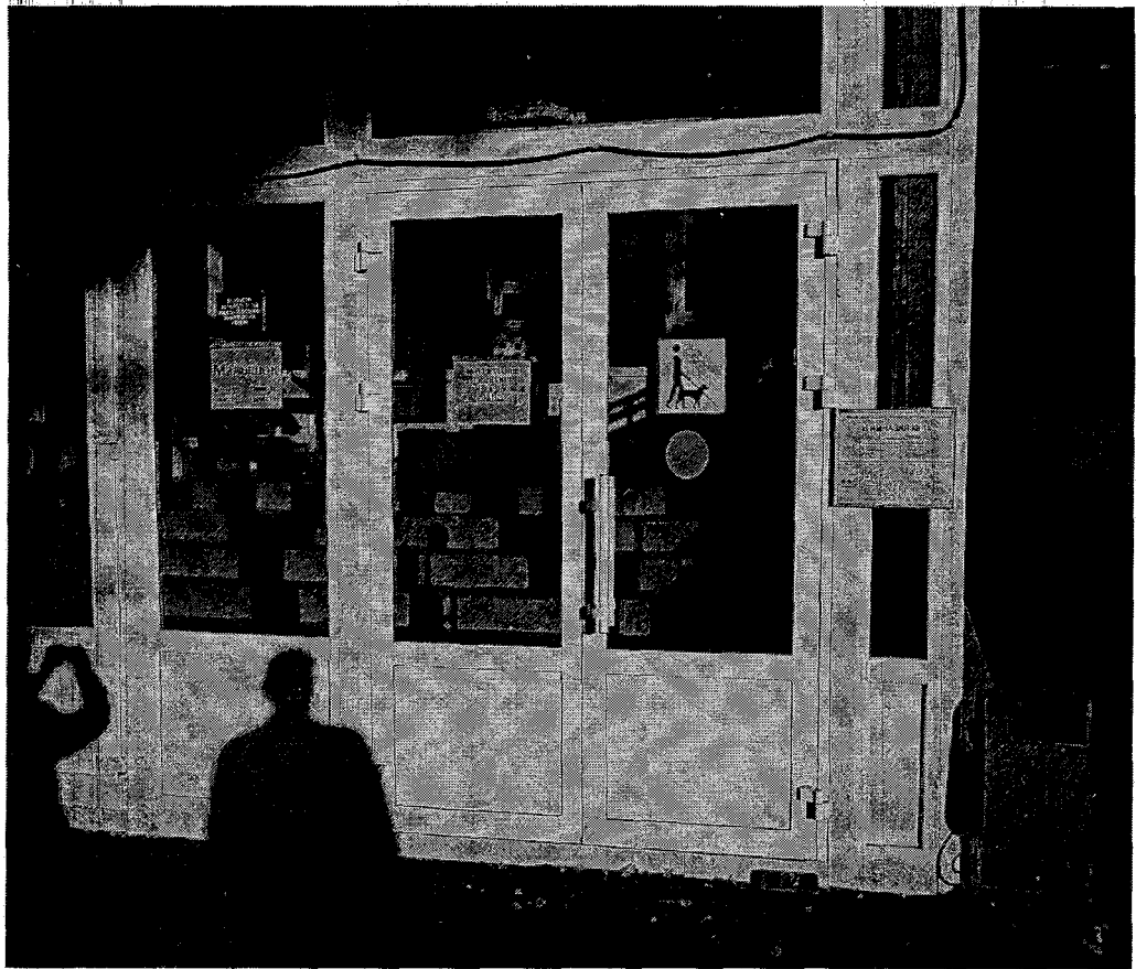
Дверь (входная, главный вход) – Фото №9
