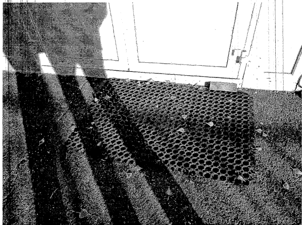
Дверь (входная, главный вход) – Фото №10
