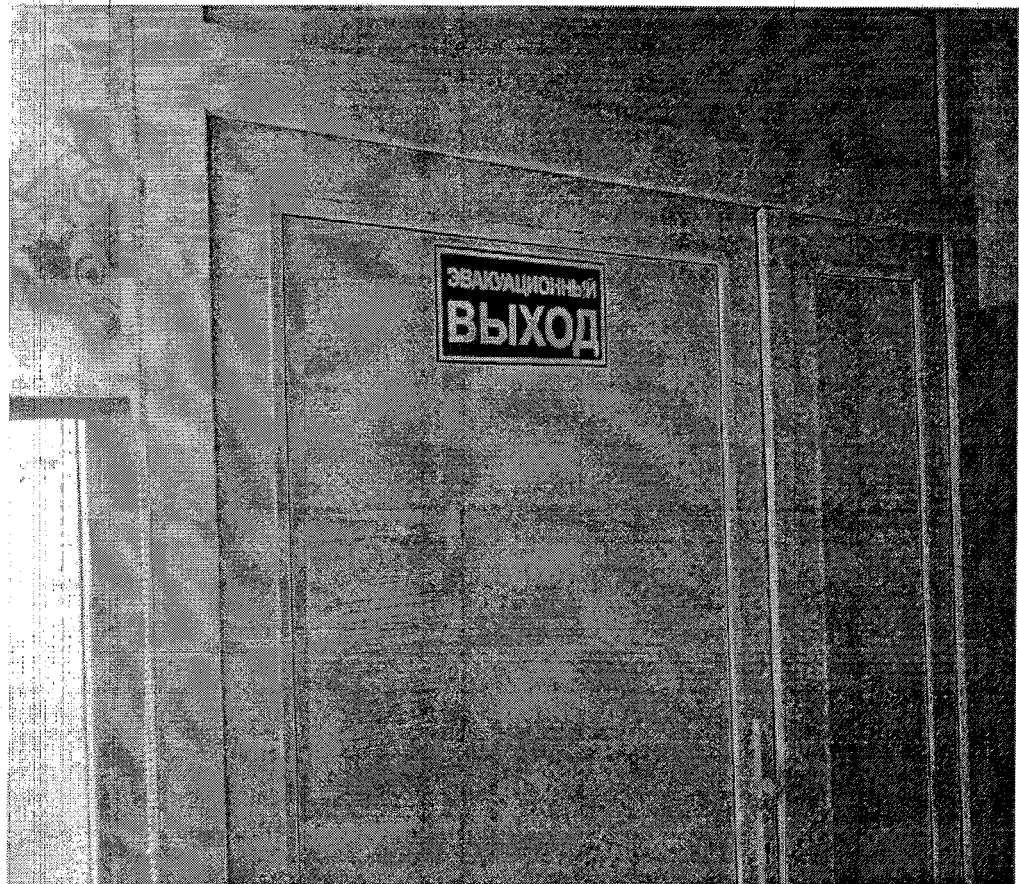
Пути эвакуации – Фото №47
