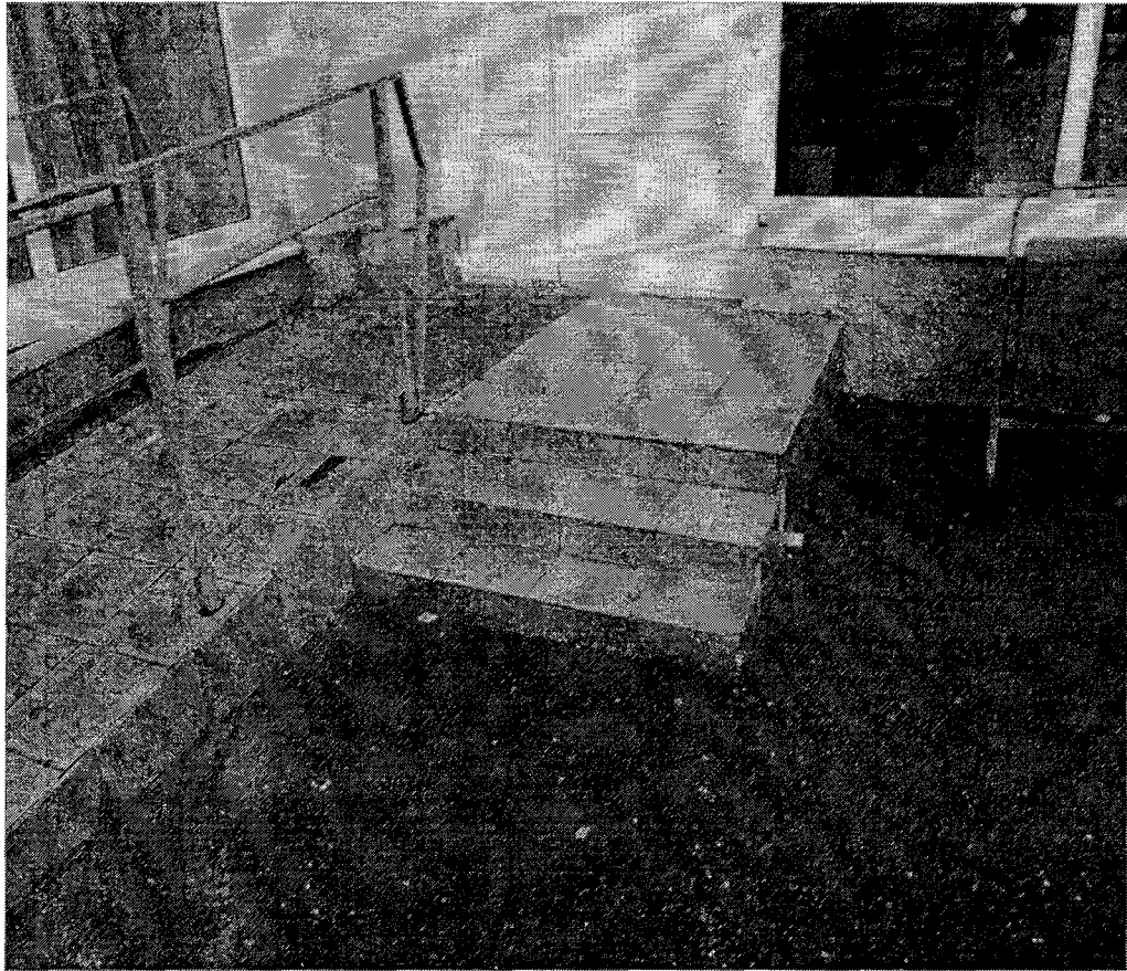
Лестница (наружная, вход №2) – Фото №5
