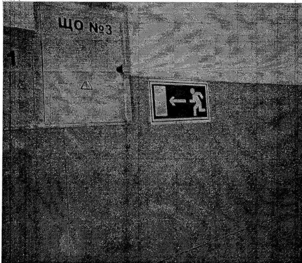
Пути эвакуации – Фото №45
